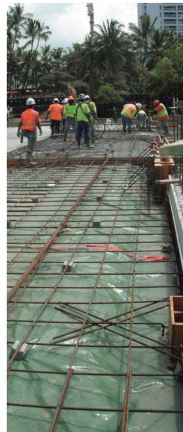
Para lograr una protección duradera contra la intrusión de humedad y las fallas potencialmente costosas del piso, elija un protector/retardador de vapor con una de las clasificaciones de permeabilidad más bajas de la industria y casi dos veces la resistencia a los pinchazos que tienen otros sistemas – PERMINATOR.
